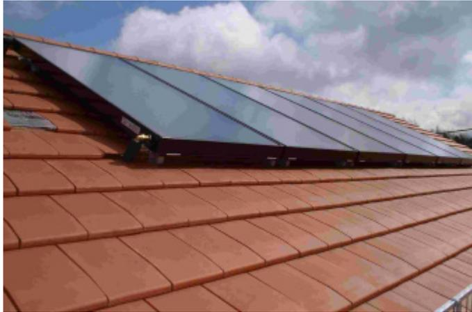
Bild 26: Flachkollektor auf dem Dach des Referenzgebäudes.
