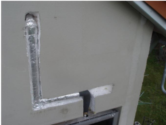
Bild 36: Verrohrung der Fassadenkollektoren (Beispiel).
