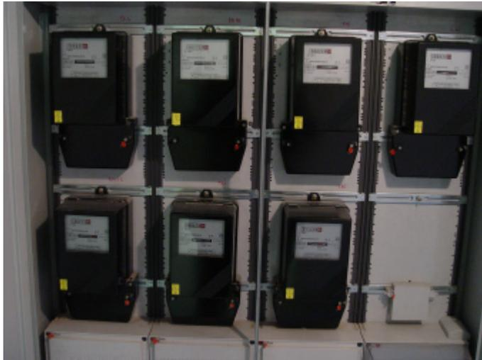
Bild 50: Elektrozähler zur Handablesung der Verbräuche in den einzelnen Wohnungen sowie der Hilfsenergie für die Heizungsanlage.
