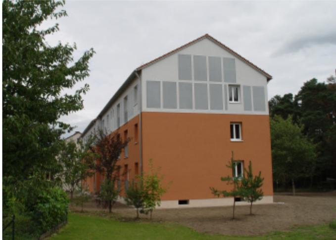
Bild 14: Südansicht des Innovativgebäudes nach der Sanierung mit TWD und HTWD
