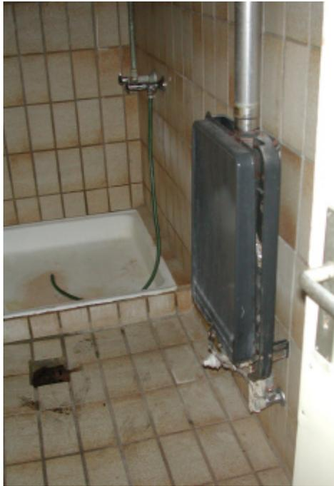
Bild 8: Warmwasserbereiter im Duschaum .
