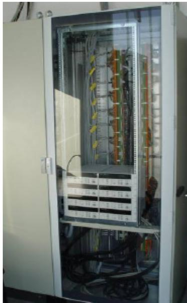
Bild 46: Messdatenerfassungszentrale im Heizungsraum des Innovativgebäudes.
