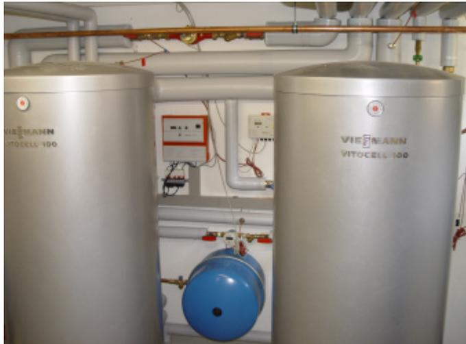
Bild 24: Trinkwasserspeicher und Pufferspeicher im Innovativgebäude nach der Sanierung.
