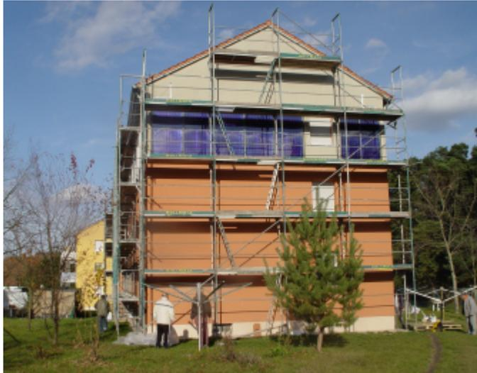
Bild 34: Montage des südorientierten Fassadenkollektors.
