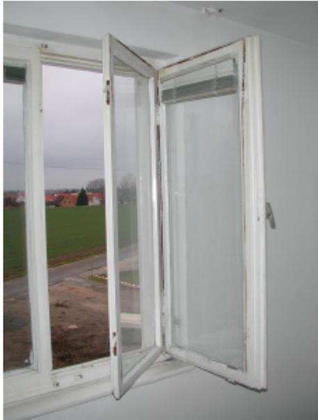
Bild 6: Zwei-Scheiben-Verbundfenster mit Klarglas vor der Sanierung.
