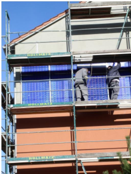
Bild 33: Montage des südorientierten Fassadenkollektors.
