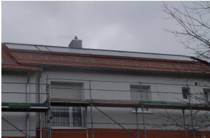
Bild 32: Röhrenkollektor am Innovativgebäude.
