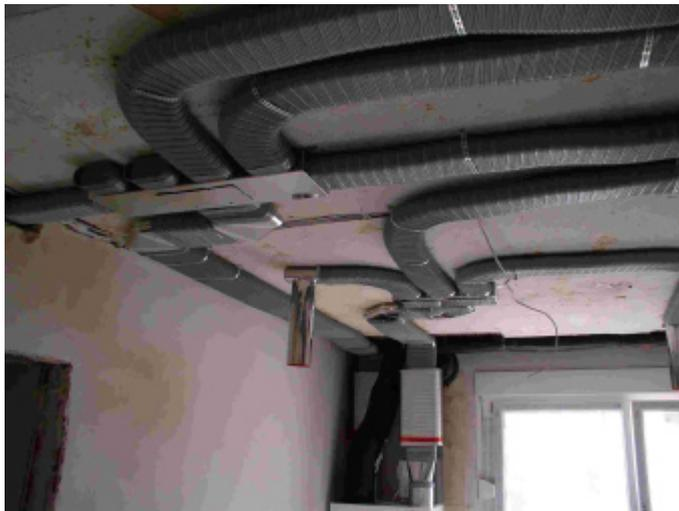
Bild 38: Verteilung der Lüftungskanäle unter der später abgehängten Decke.
