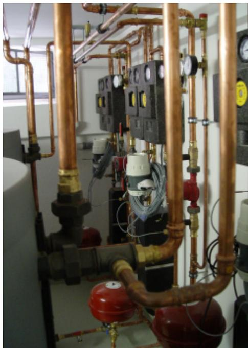
Bild 25: Verteilungssystem im Innovativgebäude mit Pumpstationen für Flachkollektor, Fassadenkollektor und Röhrenkollektor.
