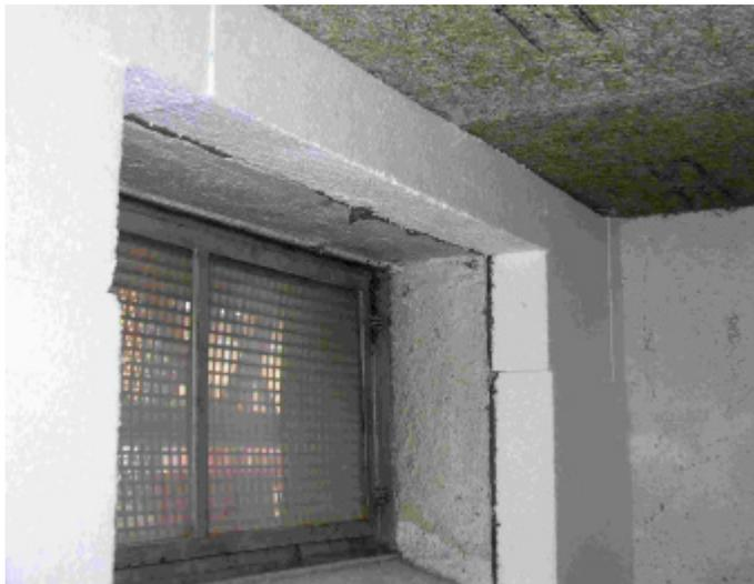
Bild 17: Detail zur Dämmung der Kelleraußenwand des Innovativgebäudes im oberen Wandbereich.
