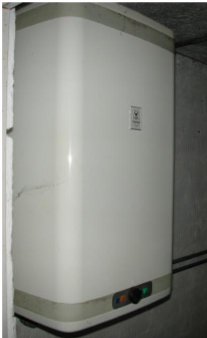
Bild 9: Elektroboiler zur Warmwasserbereitung.
