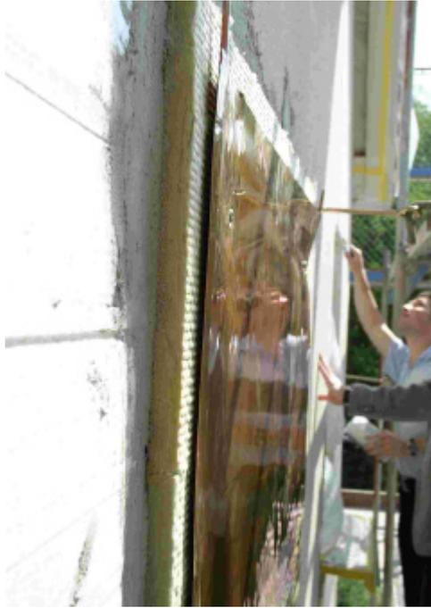
Bild 29: Detail zum Aufbau der HTWD am Innovativgebäude (Montage Absorberelement).
