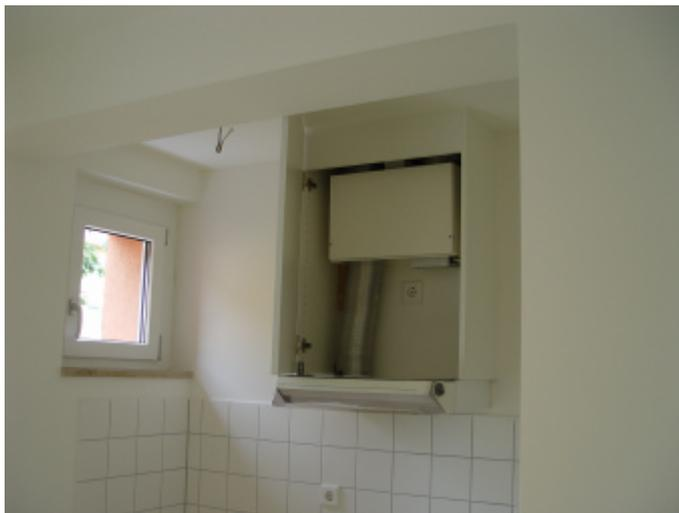
Bild 40: Abluftanlage im geöffneten Zustand.
