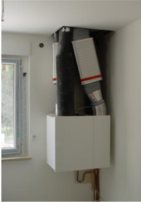
Bild 39: Lüftungsanlage im geöffneten Zustand.
