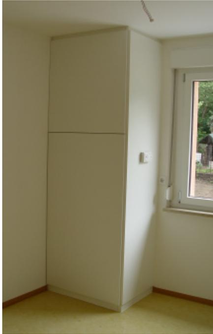
Bild 37: Schrank einer Be- und Entlüftungsanlage mit Wärmerückgewinnung.
