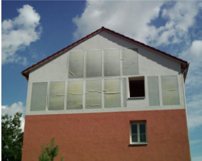
Bild 31: Fotografische Aufnahme des Schadensfalls an der HTWD wegen Überhitzung.
