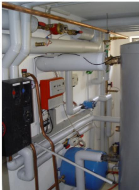
Bild 23: Detailansicht der Installation der Heizungsanlage (rechts Trinkwasserspeicher) im Innovativgebäude nach der Sanierung.
