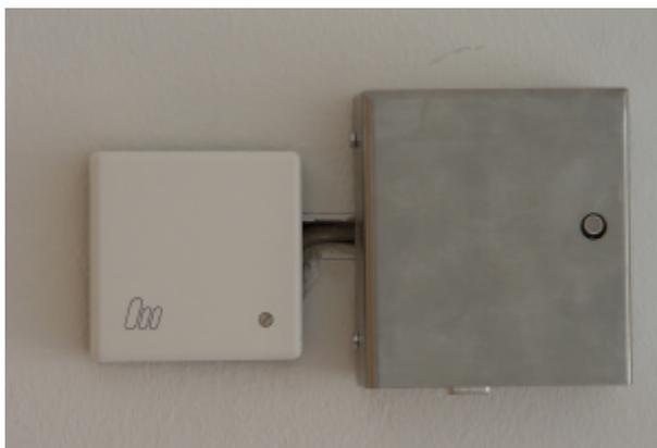
Bild 51: Kombierter Raumlufthtemperatur- und Raumlufthfeuchtefühler (links) und Luftqualitätsfühler (rechts).
