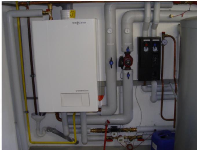
Bild 22: Brennwerttherme im Innovativgebäude nach der Sanierung.
