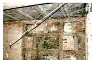
▲ Abb. 1 Aufnahme der oberen Wohnstube in Richtung Westwand. Deutlich erkennbar sind die Originalbacksteinausfachungen dieser barockzeitlichen Fachwerkwand, auf der sich jedoch nur minimal Putze aus der Bauzeit erhalten haben.
