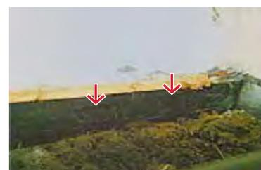
▲ Abb. 3 Ehemaliger Unterzug mit den beiden Sassen der Kopfbänder zum nicht mehr vorhandenen Außenfachwerkständer. Der schwarze Bisteranstrich in den Verbindungen ist klar ablesbar, ebenso der nachträgliche Einbau der Lehmwickeldecken.
