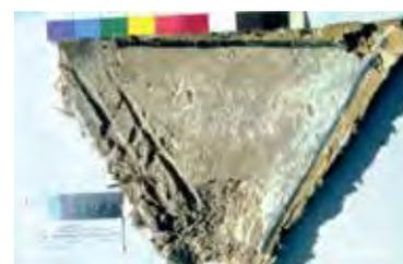
▲ Abb. 6 Aus dem Altanenanbau: Lehmgefach mit den typisch neuzeitlichen rautenförmigen Einritzungen der Lehmfläche und der dünnen Kalkputzschicht mit ockerfarbiger Balkenanstrichverbreiterung zur hell gekalkten Fläche und zu schwarzem Ritzer.
