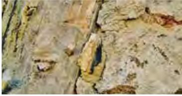
▲ Abb. 1 Westfassade: kleiner Befundputz mit Beleg einer gelben Ockerfassung des Fachwerks zu hell gekalktem Gefachputz und mit schwarzem Ritzer
