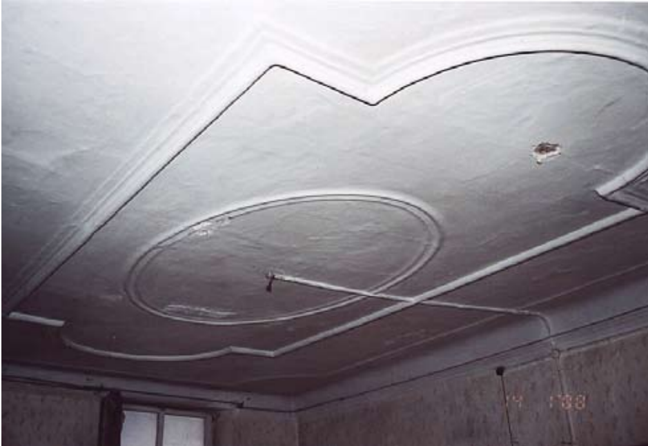
▲ Abb. 19 Raum 1.02: Diese Stuckdecke unterscheidet sich aufgrund ihrer Machart erheblich von den Stuckdecken in den ursprünglich einen bildenden Räumen 1.01 und 1.10. Hier handelt es sich eindeutig um Stuckdecken aus der Zeit des Biedermeiers (erste Hälfte des 19. Jahrhunderts). Diese Decke jedoch weist im Vergleich wesentlich kräftigere Profilierungen auf und auch die Art der Gestaltung der Spiegelfelder lässt nach Ansicht des Verfassers eher eine Ausführung noch in der Barockzeit vermuten.
