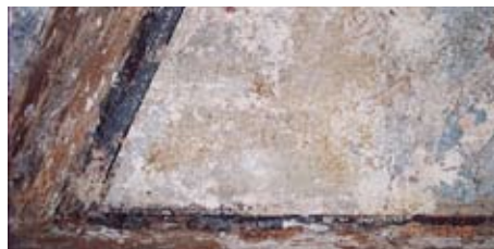
▲ Abb. 25 Der Putz in seiner ursprünglichen Graufassung mit schmalen, schwarzen Ritzen (Linien).
