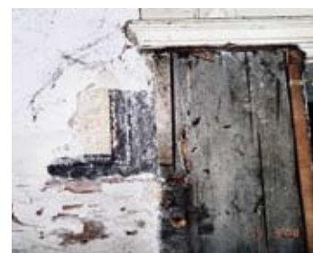
▲ Abb. 23 Ein mit grauen Farbbefunden erhaltener Gefachputz in Verbindung zur Türverkleidung des frühen 18. Jahrhunderts (linkes Stockbrett abgenommen). Auf dem Türständer ist deutlich eine („jungfräulich“) erhaltene Graufassung des Fachwerks mit Verbreiterung auf den hell gekalkten Gefachputz und schwarzer Ritzerlinie erkennbar (weiße Pfeile). Wohl bestand das zeitgleiche Blatt aus einer schlichten Brettür zwischen den Ständern, das zu Beginn des 18. Jahrhunderts durch eine Türe mit diesem Stock ausgetauscht wurde. Die der Erstfassung folgenden Überarbeitungen – ebenso in Grau – nahmen sicherlich bezug zum Verlauf des Türstocks. Leider ließ sich die Vermutung nicht mehr verifizieren, weil der Putz während der Instandsetzung „verloren“ ging.
