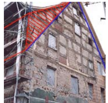
▲ Abb. 16 Pinzenberg 20. Südöstliche Fassadenansicht mit den barocken Veränderungen in Rot.
