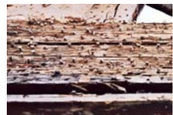
▲ Abb. 20 Die nicht vorgeblendeten Balken des Fachwerks sind mit kleinen Holzpflockchen und Nägeln „gespickt“ worden. Das gab der nachfolgenden Putzschicht besseren Halt.
