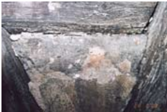
▲ Abb. 2 Beispielhaft für diese Befundsituationen einer der originalen Gefachputze an der Ostfassade.
