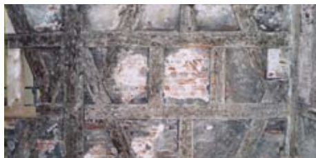
▲ Abb. 24 Beispielhaft die bauzeitliche Fachwerkwand in der oberen Wohnstube.
