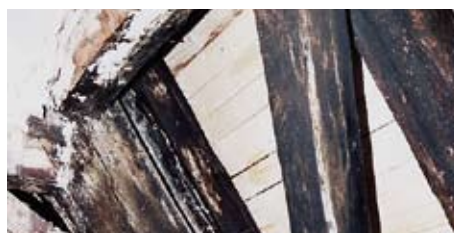
▲ Abb. 27 Detail aus dem Dachstuhl, der wie die Fassade zur Bauzeit komplett mit der Bisterlasur behandelt worden war.
