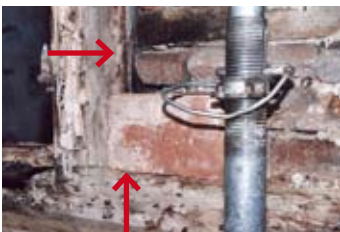
▲ Abb. 10 Dieser Backstein (Abb. 9) fügt sich mit seinen Massen und bei Hochformatvermauerung exakt zwischen dem Ansatz der hölzernen Nischenrückwand und der Vorderkante des Brustriegels am Fenstererker ein. Auf seiner Oberfläche deuten Putzspuren auf ein vollflächiges, einlagiges Überputzen der bauzeitlichen „Gefachausmauerungen“ hin.
