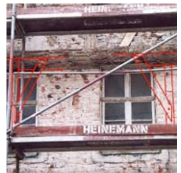
▲ Abb. 6 Südfassade, Rähmbalken im Obergeschoss mit Blattssassen: Die rote Eintragung verdeutlicht die Ständerkonstruktion mit den (jeweils nur nach einer Seite!) verblatteten Kopfbändern.
