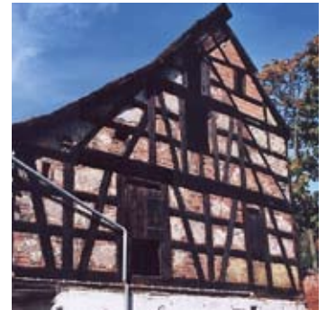
▲ Abb. 15 Das bauzeitliche Fachwerk des 18. Jahrhunderts weist parallele Konstruktionsmerkmale (Ständer-Riegel-Streben) auf wie das Fachwerk der Dachaufstockung von Pinzenberg 20. Die nördliche Dachhälfte zeigt eine Aufstockung wohl aus dem 19. Jahrhundert.
