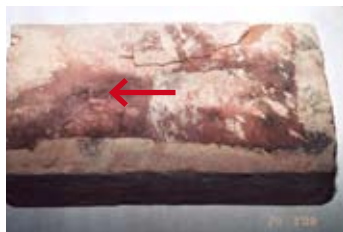
▲ Abb. 11 Im Gegensatz dazu zeigen sich auf der Rückseite des Backsteines keinerlei Rückstände einer barockzeitlichen Vermörtelung oder Überputzung. Die hellen Spritzer stammen vom Mörtel der späteren Vormauerung in der ersten Hälfte des vorletzten Jahrhunderts
