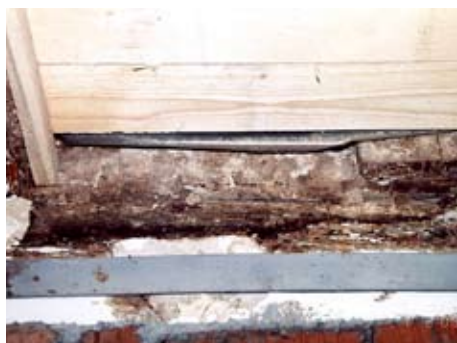
▲ Abb. 10 Raum 0.06 Wand c. Ausschnitt des Rähmbalkens – Rückseite der Stubendecke. Diese Putze liegen auf den kleinen Ausmauerungen zwischen den Deckenbalken. Sie belegen eine Farbgebung der Balken in Gelbem Ocker. Der gelbe Anstrich wurde mit schmalen Verbreiterungen auf die hell gekalkten Putzflächen gezogen und mit schwarzen Begleitlinien in Ritzerstärke akzentuiert. In dieser erst im Laufe der Neuzeit aufgetretenen „neuartigen“ Farbgebung dürfte auch die Holzdecke in der Stube gefasst (gestrichen) gewesen sein.
