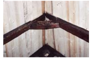
▲ Abb. 4 Dachstuhl: Am sog. Hahnenbalken sind diese drei Bohrlöcher ablesbar. Sie sind Indiz dafür, dass die mittelalterliche, östliche Dachkonstruktion wie an der Westseite aus einem Walm-dach bestand. Die Löcher stammen von den Holznägeln, die die Sparren fixierten. Auch dieser Dachstuhl wurde vor seinem Aufrichten mit der schwarzbraunen Bister-lasur gestrichen.
