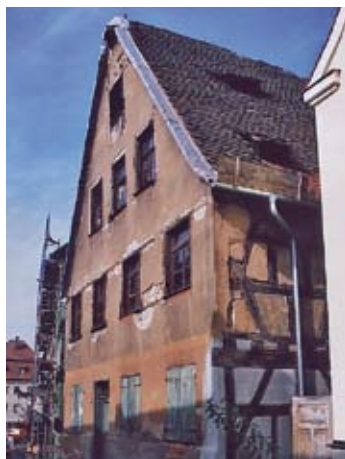
▲ Abb. 15 Südöstliche Fassade
