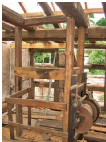
▲ Pinzenberg 20a: Der handkurbelbetriebene Aufzug, der heute in einem Schaukasten im Erdgeschoss der Scheune zu sehen ist, an seinem originalen Einbauort im ersten Obergeschoss.
