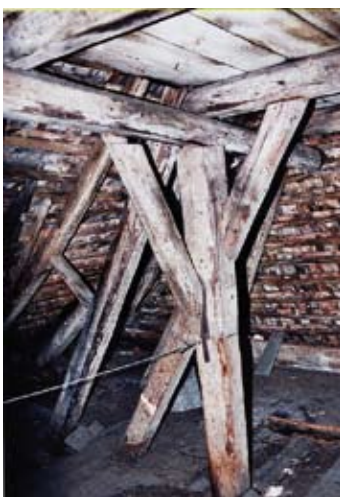
▲ Abb. 3 Zweites Dachgeschoß: Detail mit „schebbs“ stehender Säule
