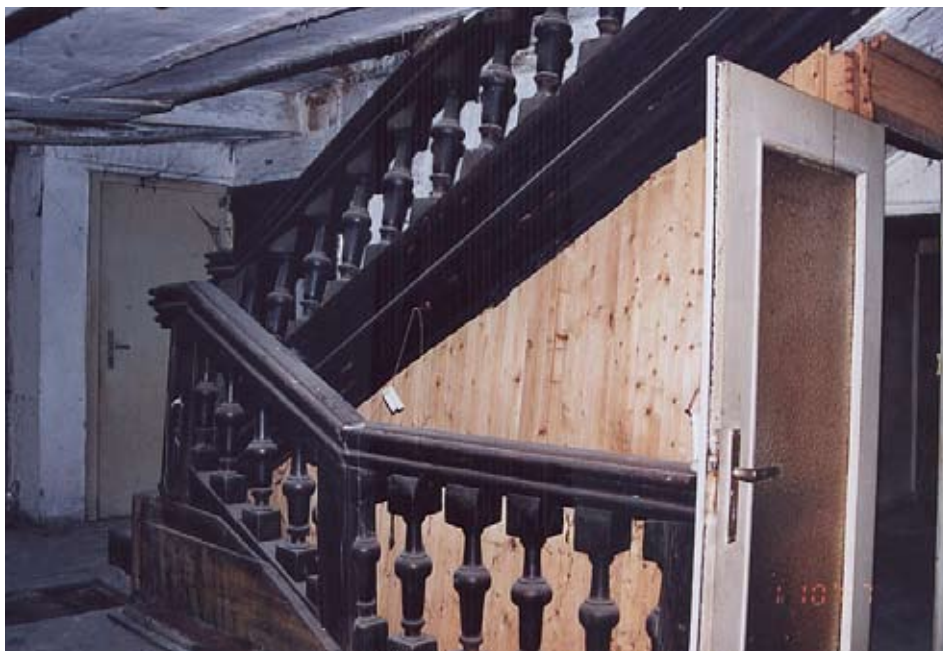
▲ Abb. 18 (Vorzustand 2007) Barocke Treppenanlage in der Diele des ersten Obergeschosses
