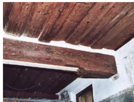
▲ Abb. 9 Wie erwähnt, wurde der Speicherbau zu einem Wohnhaus umgeplant. Zu den damals nachfolgend eingebauten Ausstattungselementen gehört auch diese Bretterbalkendecke in der Wohnstube (Raum 0.08) im Erdgeschoss. Bedauerlicherweise wurden wohl in den 60/70er Jahren des letzten Jahrhunderts ihre Oberflächen sandgestrahlt und mit Holzschutzlasuren behandelt. Im Geschoss über diesem Raum hat sich gleichfalls eine solcher Deckentypus konserviert, allerdings wird diese Decke heute durch eine Putzdecke mit biedermeierlichen Stuckfeldern abgedeckt.
