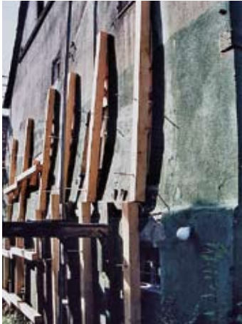
▲ Abb. 1 Stützgerüst der östlichen Außenwand
