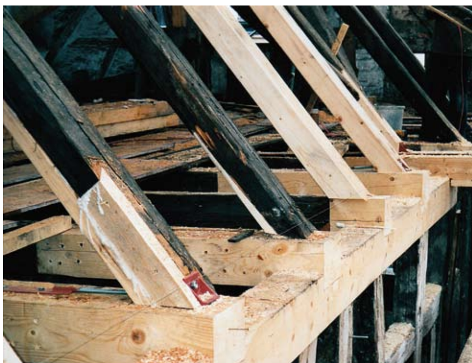
▲ Pinzenberg 20a: Umfangreiche Zimmermannsarbeit an der Traufe: Ergänzende und ersetzte Zerrbalken, Sparren-
