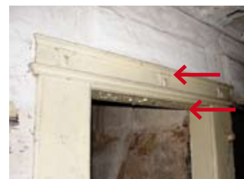
▲ Abb. 22 Barockzeitliches Türgewände zu Raum 0.02. Auffällig, dass der Türstock trotz seiner aufwendigen Gestaltung mit Zierprofilen und Kapitellen in keine verputzte, sondern immer noch in das bauzeitliche Fachwerkgefüge integriert worden ist.
