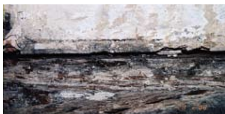
▲ Abb. 26 Selbst in Kammern wurden die Fachwerk- und Lehmdeckenputze in die graue Fassung mit schwarzen Ritzen einbezogen.
