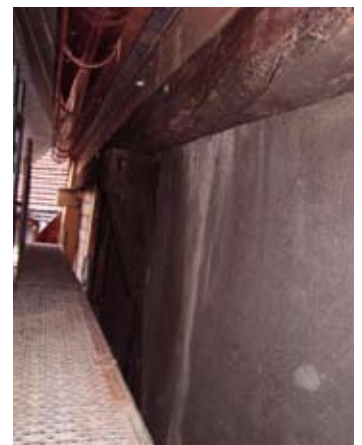
▲ Abb. 5 Rähmbalken Obergeschoss zum Dachstuhl. Unterhalb des Unterzuges eine kurze, gerade Kragge am mittelalterlichen Fachwerkständer. Ein markanter Beleg für eine zeittypische Vorkragung um Balkenstärke (Aufnahme: Robert Rester).
