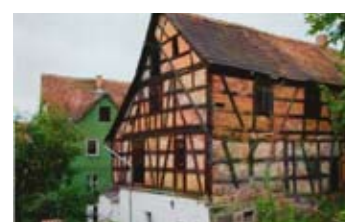
▲ Die Scheune auf dem rückwärtigen Teil des Grundstücks: Sie diente als Lager für Gerste, Hopfen, Malz und für Feuerholz für den Braukessel.
