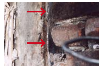
▲ Abb. 12 Die Innenseite einer der Fensterstiele bzw. einer der ursprünglichen Nischen. Deutlich sind die Fassungs-grenzen zur nicht mehr vorhandenen hölzernen Rückwand ablesbar. Die Fachwerkfarbigkeit im Innenraum bestand zu jenem Zeitpunkt aus einem grauen Anstrich, der durch die nachfolgende Ausmauerung der Nische im 19. Jahrhundert verdeckt wurde.
